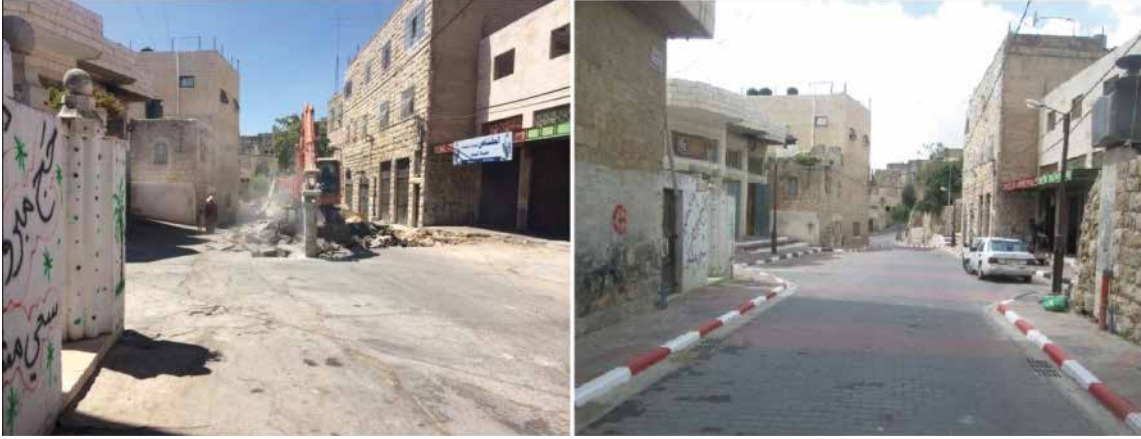
صور للشوارع قبل وبعد تأهيل البنية التحتية
