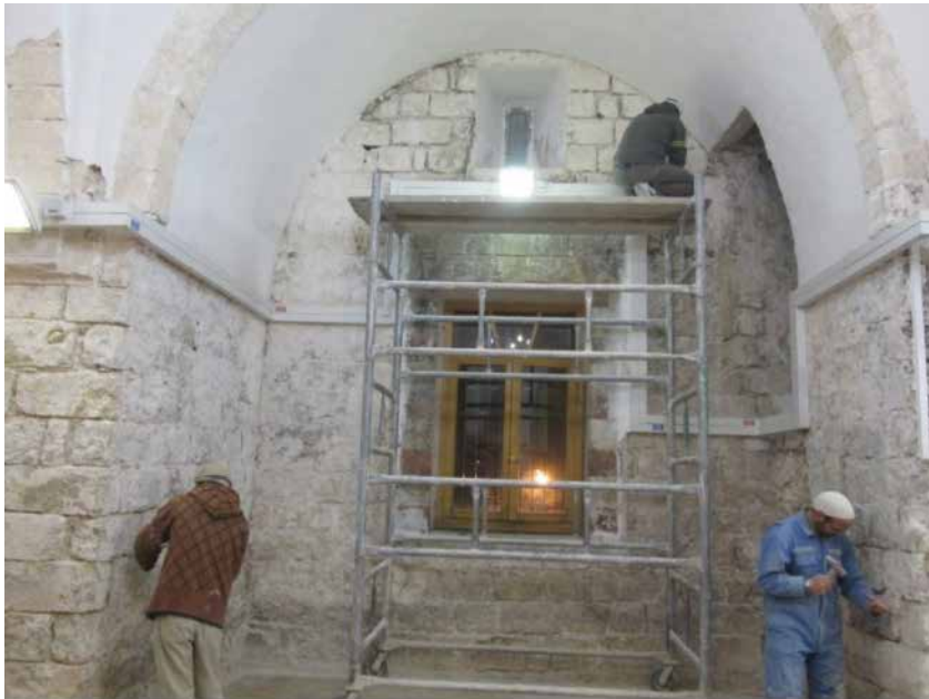
أعمال الترميم داخل الحرم الإبراهيمي
