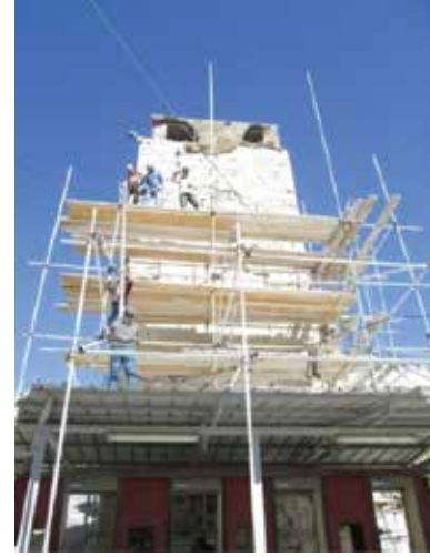
أعمال ترميم البرج
