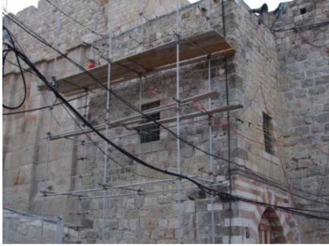
أعمال ترميم الغرفة العلوية فوق المدخل الغربي
